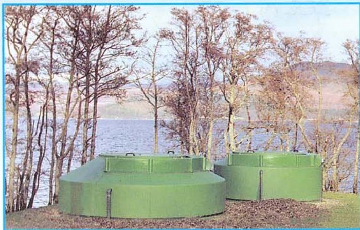
Dvostopenjska BIOCLERE čistilna naprava z dodatno enoto za odstranjevanje dušika
