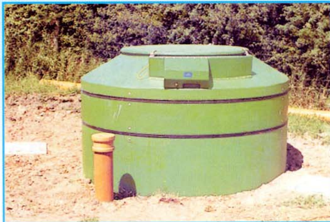
Bioclere enota za čiščenje komunalne odpadne vode za 55 PE. Možno je povečati kapaciteto z vgradnjo še dodatne enote.
