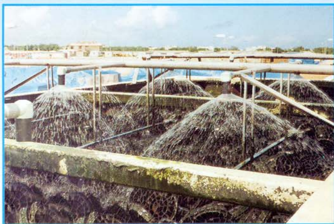
Tekočinski distribucijski sistem z nepremičnimi bio nosilci
